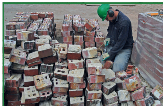
Metselstenen voor de schoorsteen van de Toekomst te Scheemda worden afgebikt en weer vermetst met 1-5-10 kalkcementmortel
