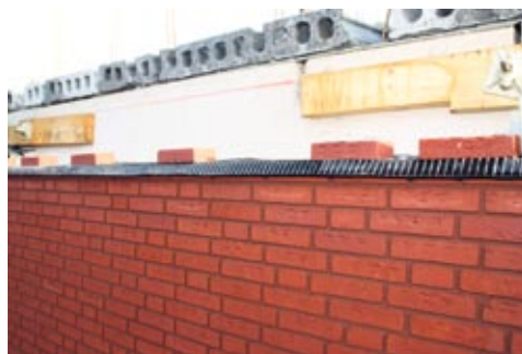
Tijdelijke bescherming van de spouwmuur tegen inwateren.
