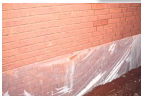
Door het aanbrengen van folie wordt het gevelmetselwerk boven het maaiveld beschermd tegen opspattend vuil en vocht.
