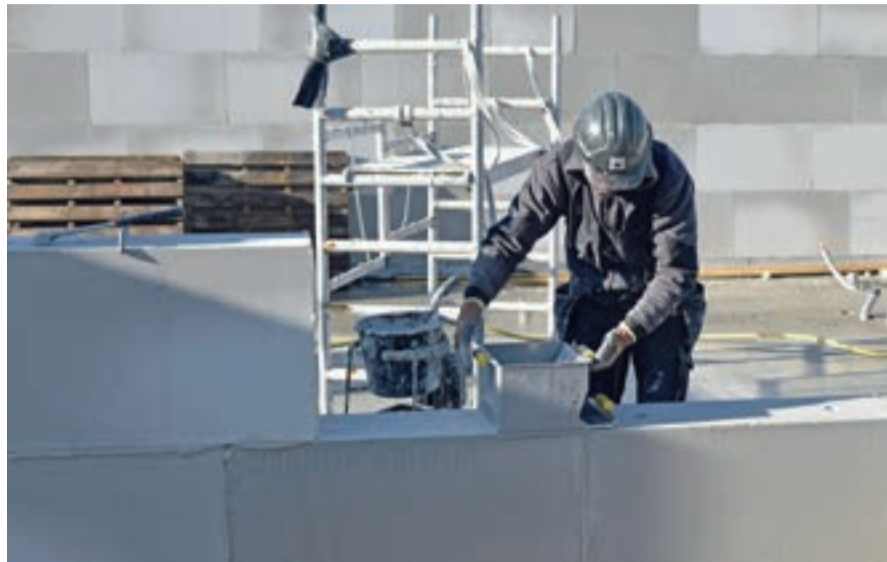
▲ Gebruik van Green Collection Blokkenlijm bij project in Oudega.
