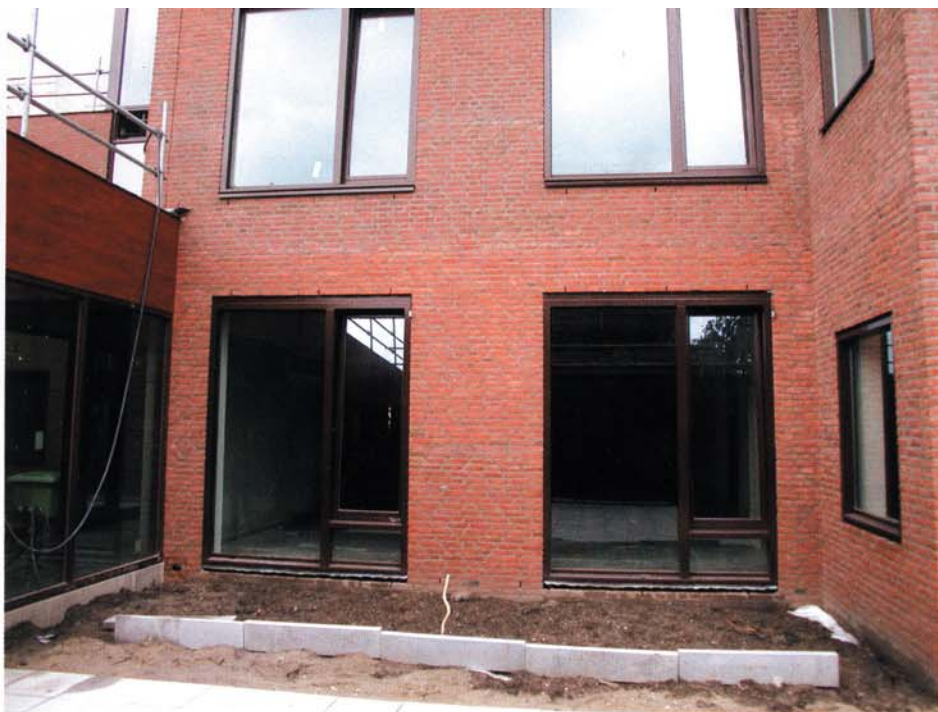
De stenen van de tweede steigerslag zijn lichter van kleur
