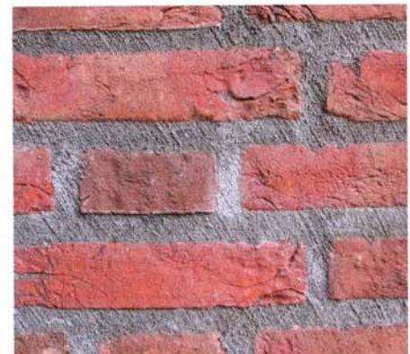
Het kleurverschil in de stootvoegen en in de lintvoegen is duidelijk te zien (beide foto's)
