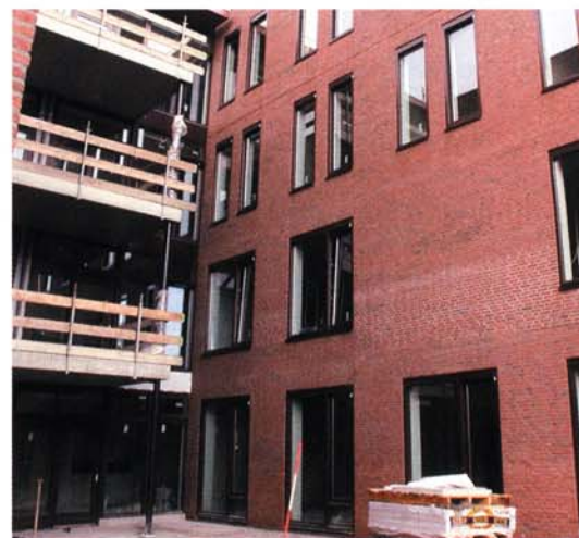
Op sommige plaatsen in het metselwerk tekent zich band- en vlekvorming af
